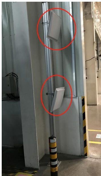
安装在车间、仓库、办公楼出入口，自动记录进出带有RFID标签的资产ID
